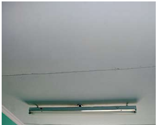
Decke im Rhein-Valley Hospital
